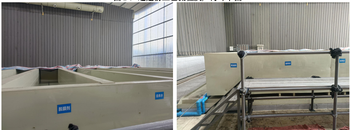
图 2-10 迁建前酸洗钝化车间
